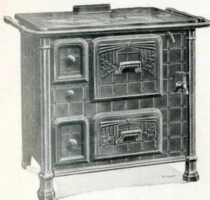
Vue d'une cuisinière à chaudière affleurant le dessus, avec barre contournante.
